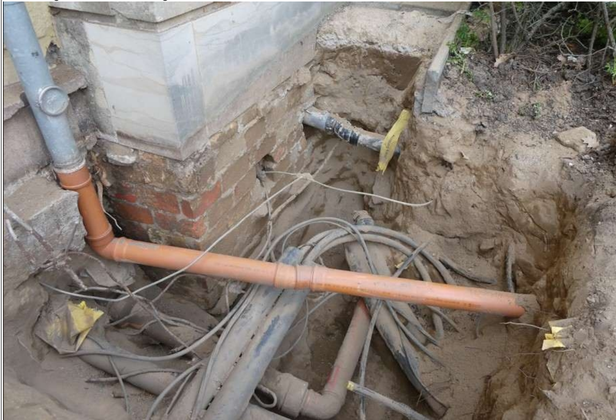
Abbildung - Suchschachtung an der Kelleraußenwand
